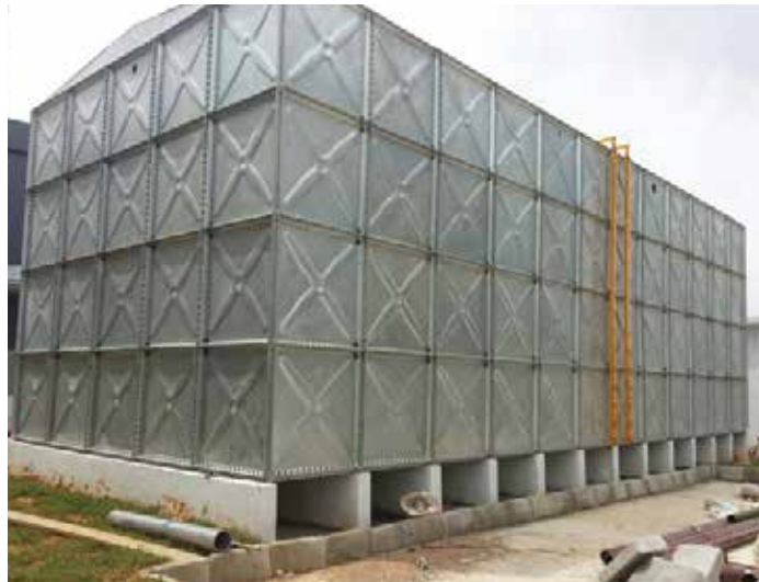
PROJEK - F&N BEVERAGE, TAMPOI JOHOR Tank Size : 48FT(L) x 20FT(W) x 16FT(H)
