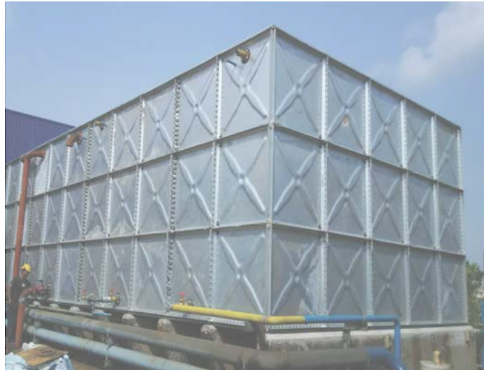
PROJEK - SHINETSU POLYMER SB SHAH ALAM Tank Size : 44FT(L) x 20FT(W) x 12FT(H)
